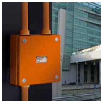
FK forgningsdåser: E30/E60/E90 beskyttelse mod brand PH120 fuld opretholdelse af funktion
