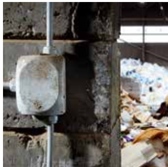
DK forgningsdåser: IP 66 til normale omgivelserforhold og beskyttet udendørs installation
