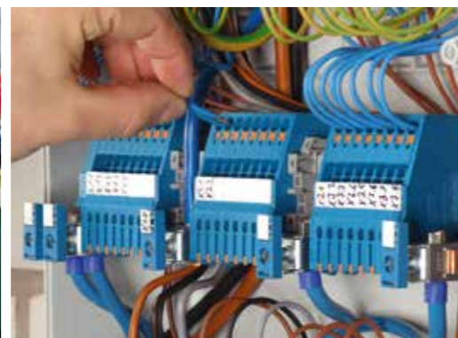
■ 中性线(N)断开端子，绝缘电阻的测量符合DIN VDE 0100-718 (德国标准)
