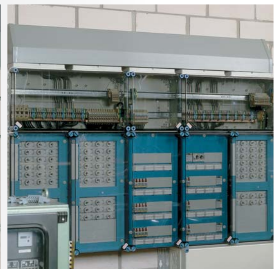
Abdeckung der Kabeleinführung mit Rangier-Kanal.
